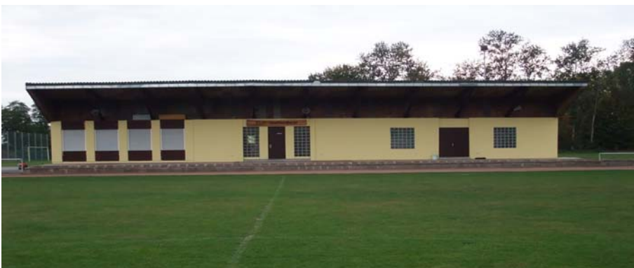
Clubhaus nach der Sanierung der Außenfassade
